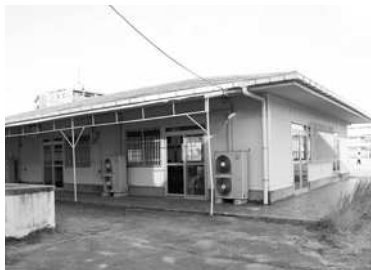
白い外壁と淡いグリーン屋根
