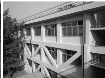
母校3号館中学校校舎耐震改修工事終了 左：校舎西側にエレベーターとスロープ設置、 右上：廊下に段差解消のスロープと一段高い 手すりを設置、右下：耐震補強用筋交い 関連記事は3頁
